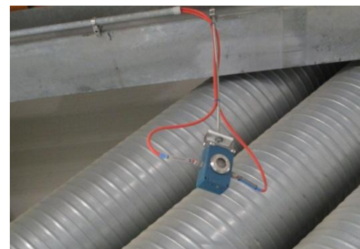
รูปที่ 3-27 ระบบตรวจจับก๊าซ (Gas Detector)
