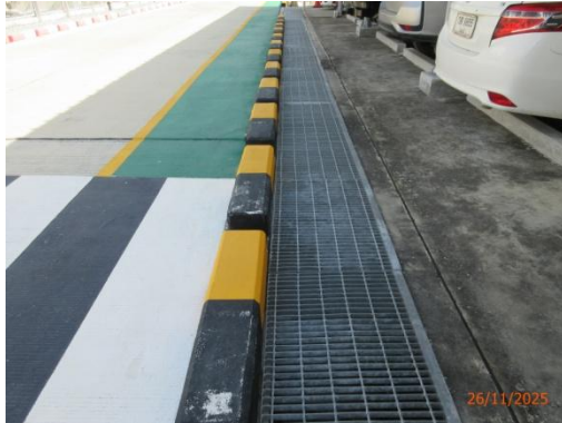
รูปที่ 3-18 ระบบระบายน้ำฝนภายในพื้นที่โครงการ
