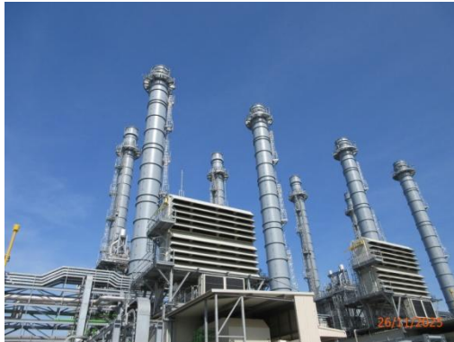
รูปที่ 3-1 ปล่องระบายจากหน่วยผลิตไอน้ำ (HRSG)
