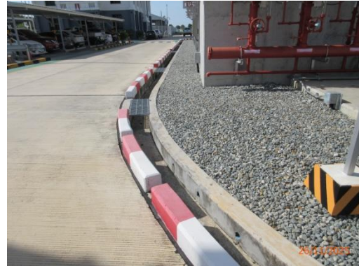
รูปที่ 3-18 ระบบระบายน้ำฝนภายในพื้นที่โครงการ
