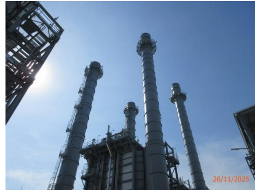
รูปที่ 3-1 ปล่องระบายจากหน่วยผลิตไอน้ำ (HRSG)
