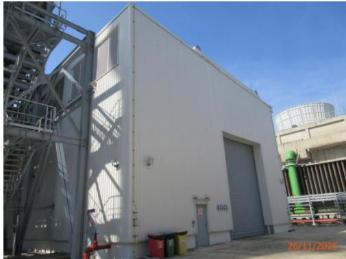
รูปที่ 3-6 อาคารครอบบริเวณเครื่องจักรที่มีเสียงดัง (Enclosure)
