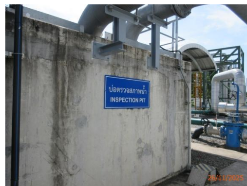
รูปที่ 3-10 บ่อตรวจสอบสภาพน้ำ (Inspection Manhole)
