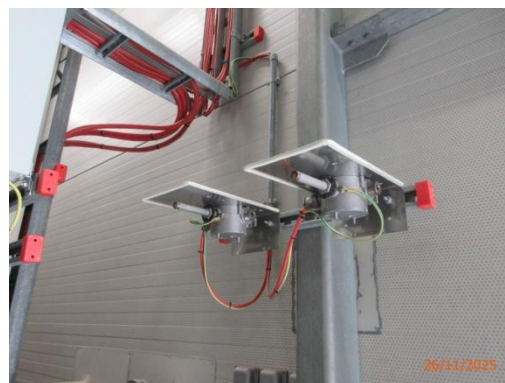
รูปที่ 3-38 การติดตั้ง Heat Detectors
