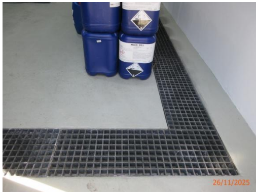
รูปที่ 3-21 ระบบระบายน้ำฝนที่มีโอกาสปนเปื้อน
