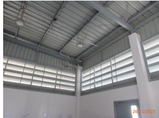
รูปที่ 3-34 พื้นที่จัดเก็บสารเคมีที่มีช่องระบายอากาศ
