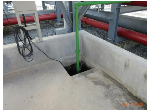
รูปที่ 3-14 บ่อแยกน้ำมัน (Oil Separator)
